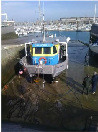
Après un bon décapage au jet haute pression sous la surveillance d'aigle des nombreux chefs de chantier, un grattage de la coque pour faire tomber les cloques, le démontage des anodes, la pose du ruban adhésif, nous attaquons la peinture de la chaîne, de l'ancre et de l'antifouling.
